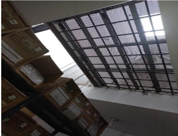
Fotografía: Ventilación y entrada de suciedad al Archivo Cetral
